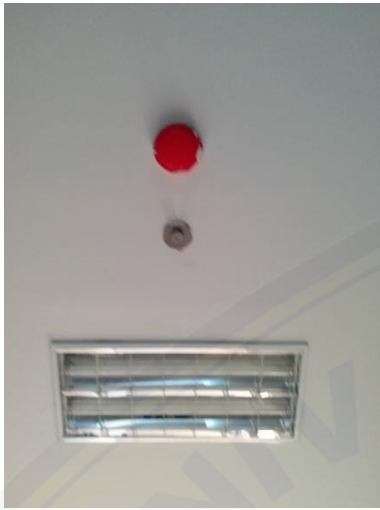
Gambar 1. Sistem Sprinkler
