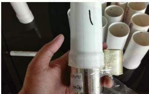
Memasang pipa pada ring dan membalutkan plastik wrap, untuk menghindari kebocoran
