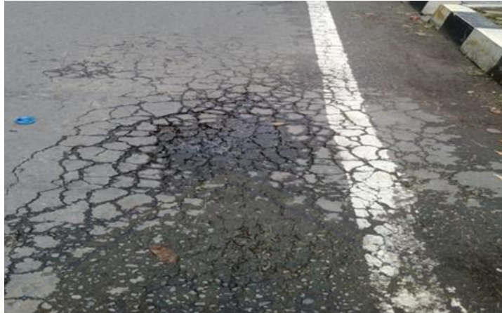
Gambar 2.2 Retak kulit buaya
