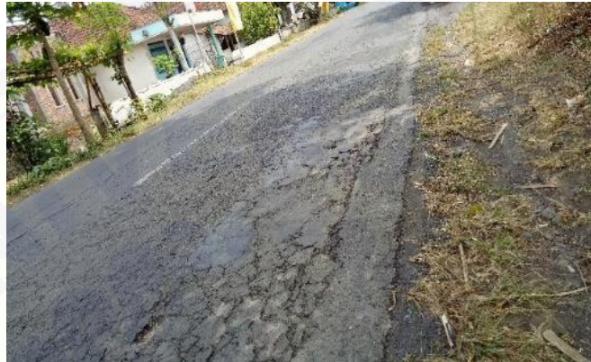
Gambar 2.11 Mengembang Sumber: Hardyatmo, 2007
