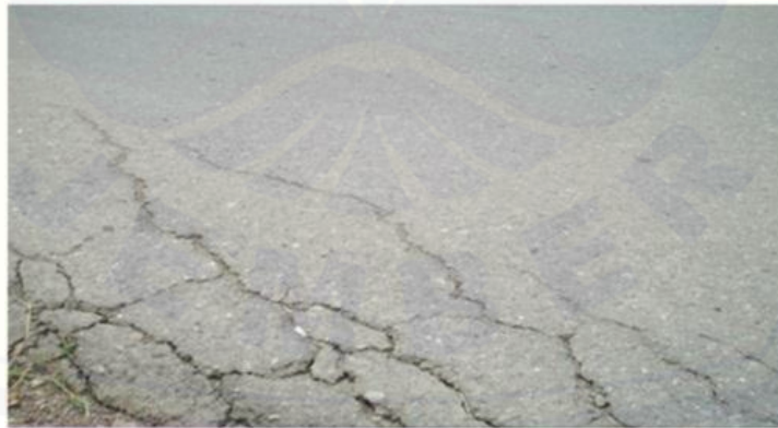
Gambar 2.3 Retak Pinggir
