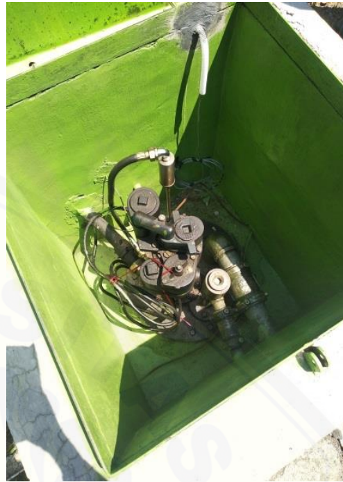
Gambar 10. Tampak atas tangki pendam SPBU
