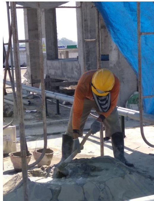
Gambar 6. Pekerja lengkap menggunakan APD
