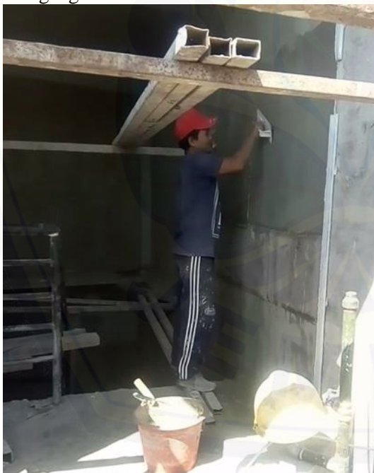
Gambar 7. Pekerja tidak memakai Body Harness
