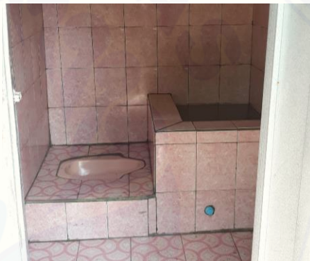
Gambar 7. Bagian dalam jamban umum yang masih digunakan
