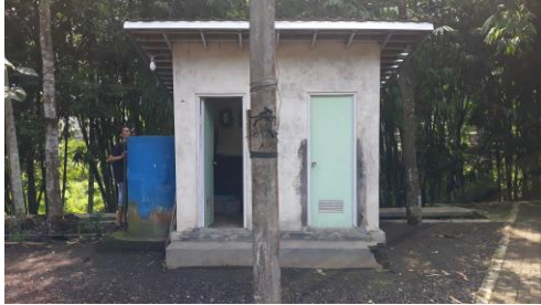
Gambar 4. Bangunan jamban umum dari pemerintah desa yang tidak digunakan
