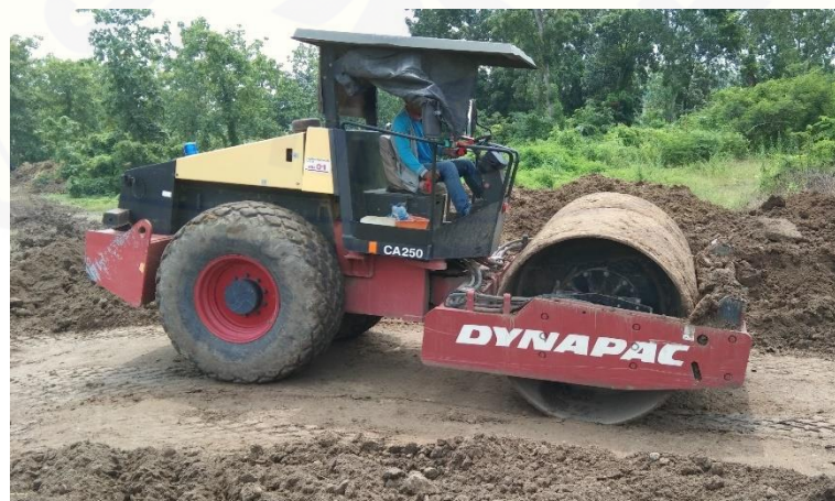
Gambar saat Vibrator Roller memadatkan Jalan Dump Truck
