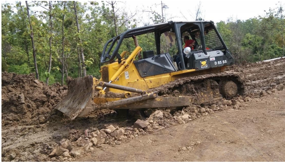
Gambar saat Dozer mundur dan ganti presneling
