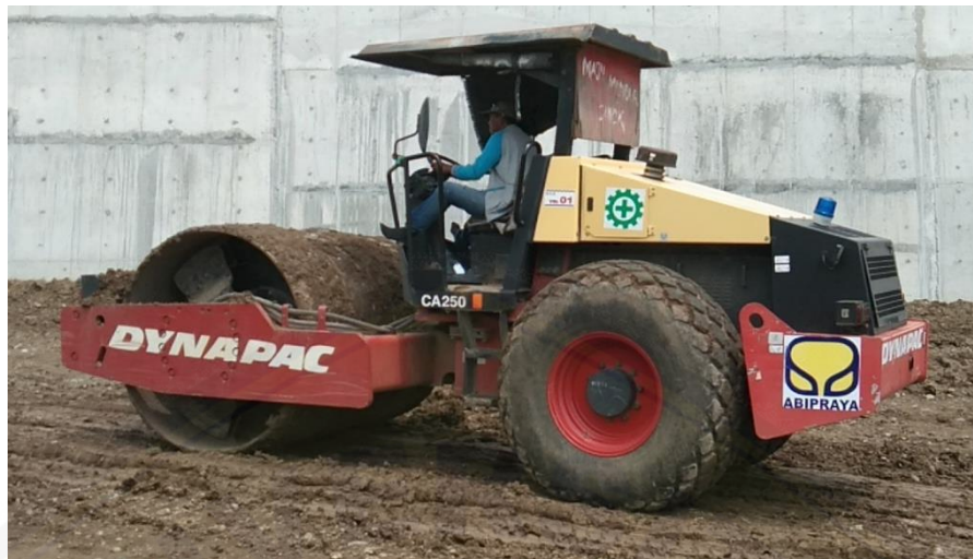
Gambar saat Vibrator Roller memadatkan tanah
