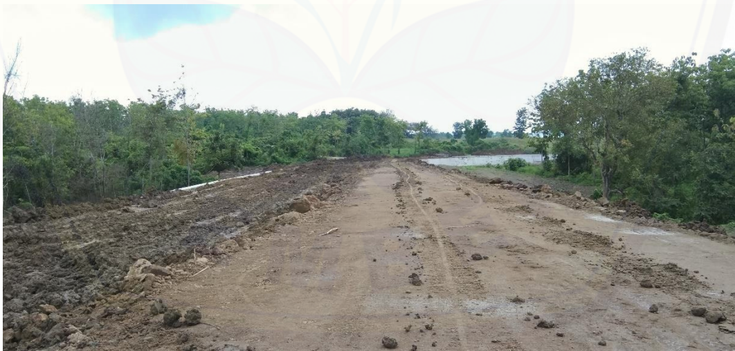
Gambar kondisi di Lokasi Jalan arah Quarry
