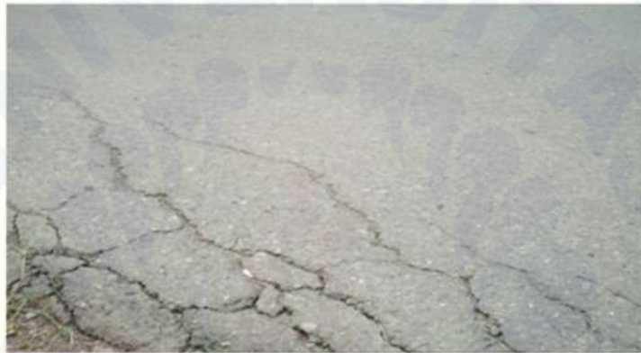
Gambar 2.3 Retak Pinggir Sumber: Hardiyatmo, 2007
