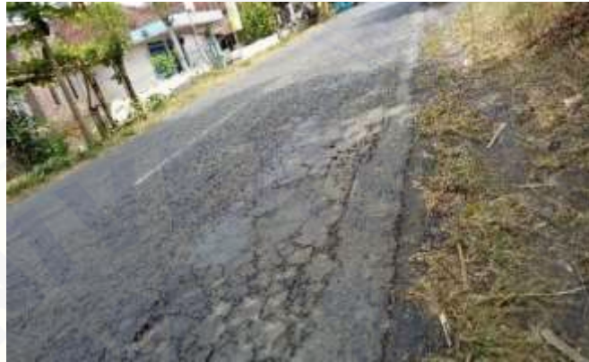
Gambar 2.11 Mengembang Sumber: Hardyatmo, 2007
