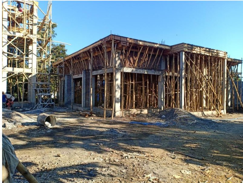
Gambar 3 : Pembangunan Masjid PMMP (baru) Sumber : dokumentasi Pribadi
