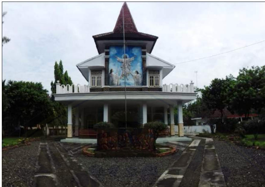
Gambar 7. Gedung Gereja Tahun Pembangunan 2012 Sumber: Dokumentasi GKJW Rejoagung
