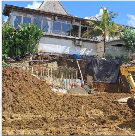
Gambar 3. 3 Kondisi Bangunan di Atas Lereng
