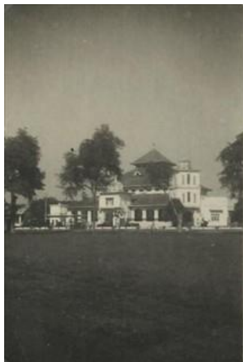
Gambar 2. 38 Masjid Jami' setelah renovasi (Sumber:
