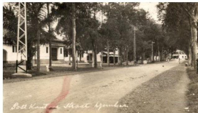
Gambar 2. 51 Jalan menuju kantor pos Jember (Sumber: https://hdl.handle.net/20.500.11840/1245282 )
