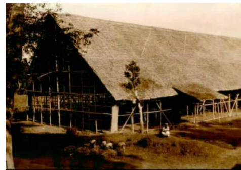
Gambar 2. 10 Gudang tembakau (a)
