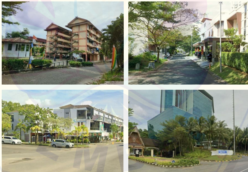
Gambar 4. 1 Penggunaan Lahan Residential di Koridor Jalan Ahmad Yani Batam (Sumber: Survei Primer, 2026)
