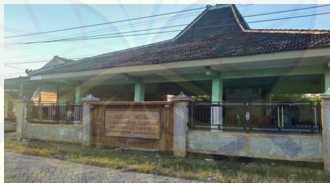
Gambar 4. 1 Balai Desa Tambakmenjangan
