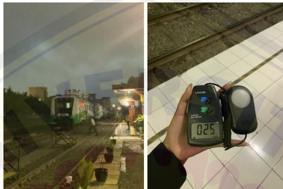
Gambar 4. 10 Kondisi Eksisting Lampu Penerangan dan Tingkat Pencahayaan Pada Aspek Keselamatan (Sumber: Hasil Analisis, 2026)
