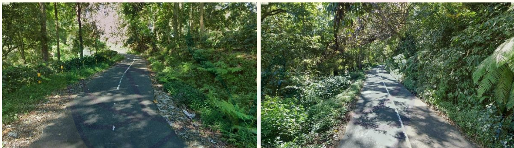
Gambar 4.9 Segmen yang Tidak Mempunyai Penilaian Star Rating Pesepeda (Kiri; KM 26+000–26+100, Kanan; 27+000–27+100)
