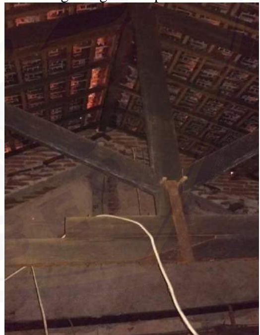
Kondisi struktur atap gedung kampus 1
