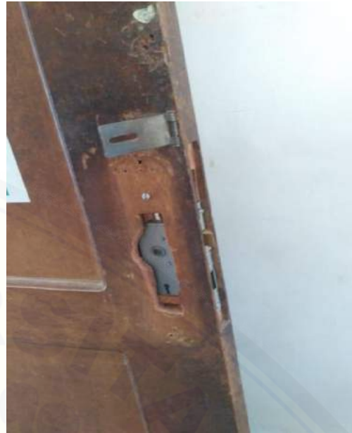
Kondisi kunci pintu yang lepas pada kampus 3 gedung B
