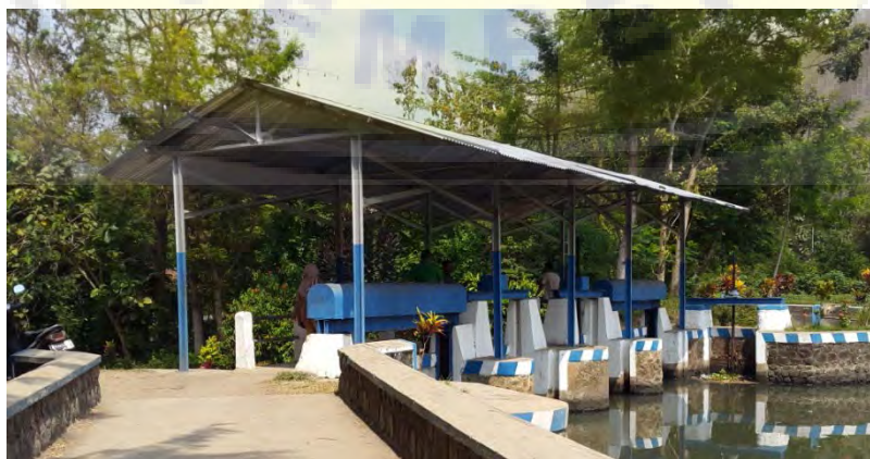
Gambar 2. Foto Dam Karanganyar
