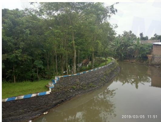
Gambar 5. Lokasi Sub DAS Pace
