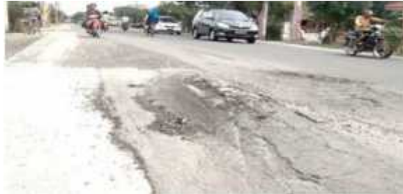
Gambar 2.15 Jembul ( upheaval ) (Sumber : Sumantri, 2015)
