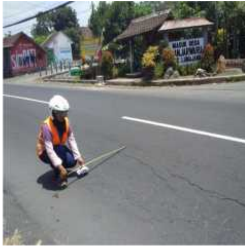
1. Pengukuran Kerusakan jalan
