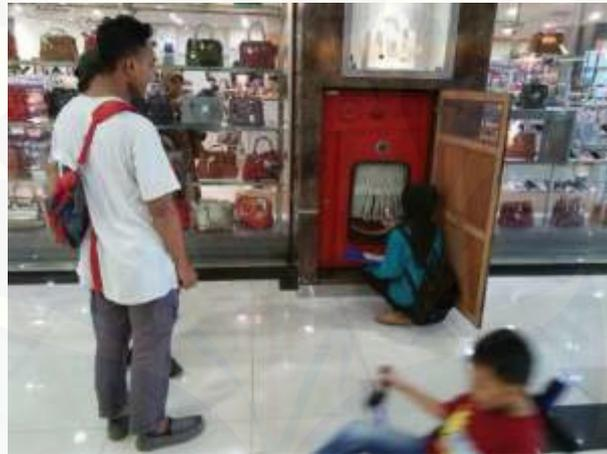
Gambar 11. Observasi instalasi hidran di *floor* pusat perbelanjaan Golden Market Jember
