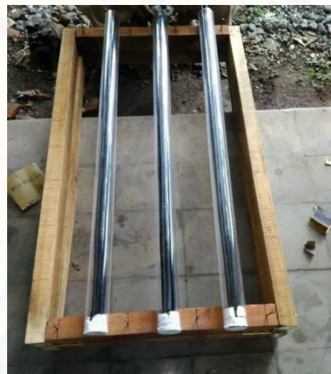
Gambar Lampiran b). Pemasangan kolektor
