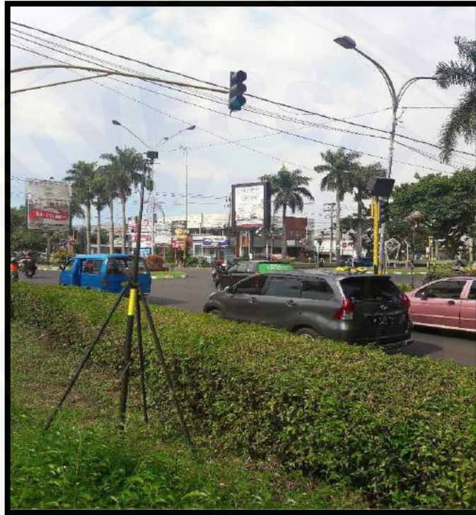
Pemasangan kamera pada pendekat JL. Raya Langsep
