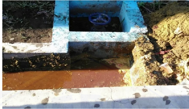
Hasil pengerukan isi rumen, kotoran dan sisa lemak sebelum memasuki IPAL di RPH Kaliwates
