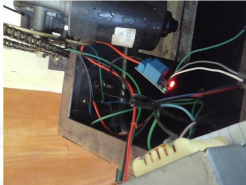
Gambar 7. Pemasangan relay pada motor listrik
