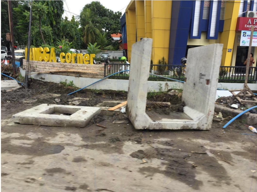
Gambar 1. Box Culvert yang Digunakan untuk Sistem Drainase Jalan Darmawangsa
