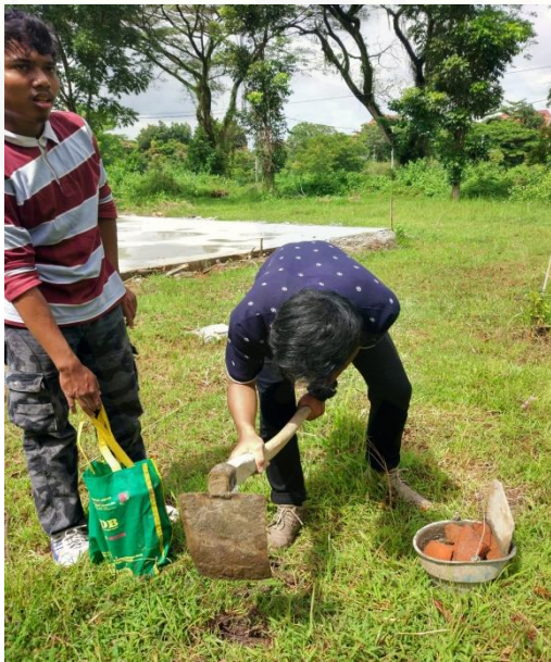
Gambar11. Pembuatan Lubang Patok BM2
