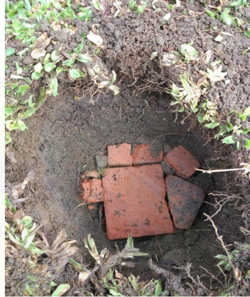
Gambar 6. Pelapisan Dasar Lubang
