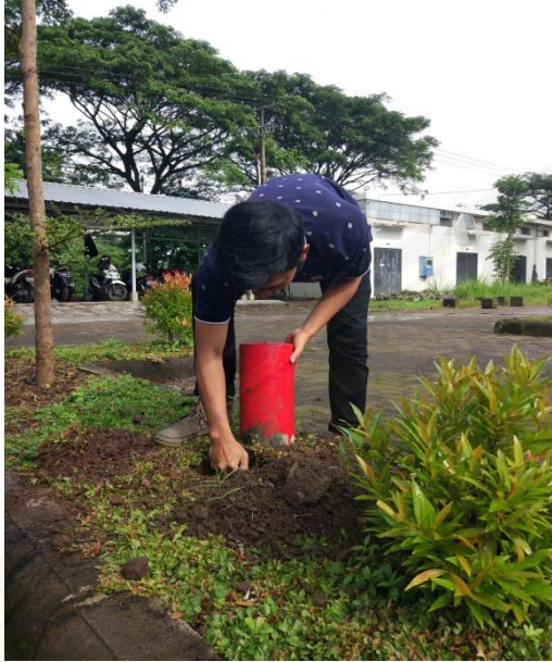
Gambar 5. Pembuatan Lubang Patok BM1
