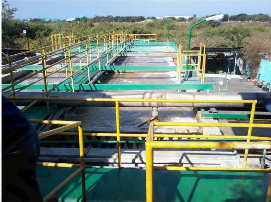
Gambar 16. Kolam pengelolaan air limbah pada WWTP
