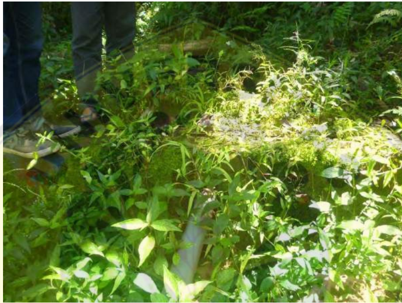
Gambar L.3.3 Kondisi Bangunan Broundkap Teratai
