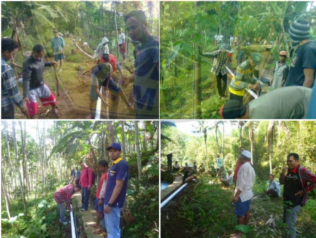
Gambar 2. Pemasangan Jaringan Pipa dia 3" di Kedua HIPPAM
