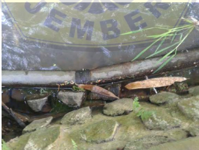
Gambar L.3.2 Kondisi Pemasangan Pipa Eksisting
