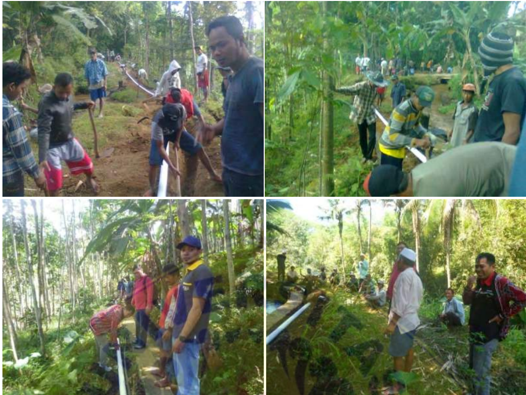
Gambar 5.2. Pemasangan Jaringan Pipa dia 3” di Kedua HIPPAM
