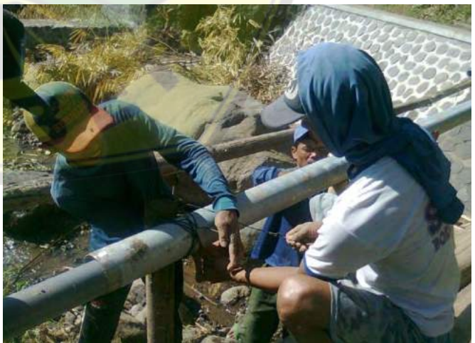
Gambar L.5.4 Dokumentasi Kegiatan Pemasangan Pipa (HIPPAM Gading)
