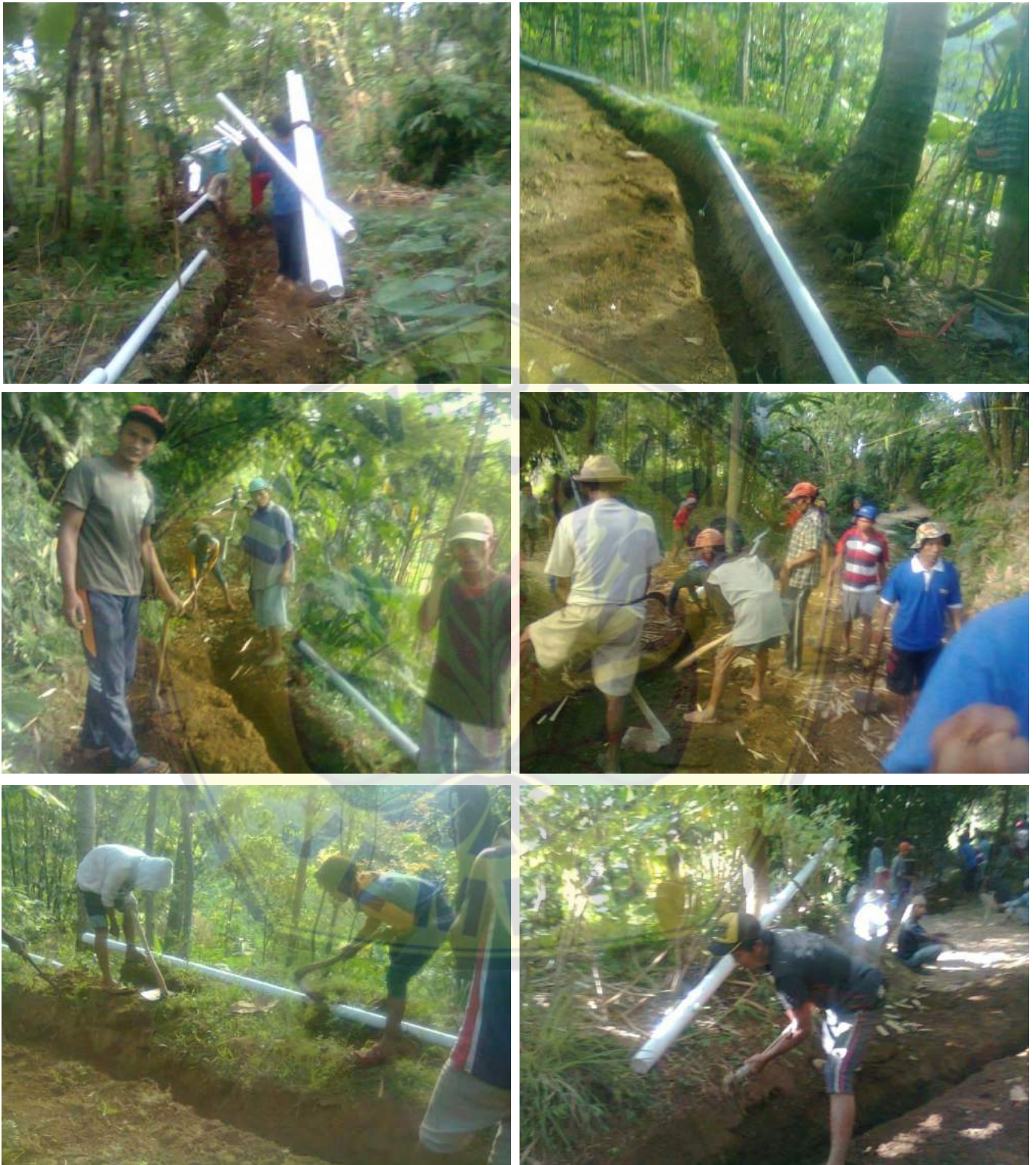
Gambar L.5.1 Dokumentasi Kegiatan Pemasangan Pipa (HIPPAM Gading)
