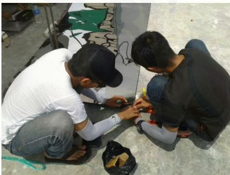
Pemasangan Pengunci Colektor
