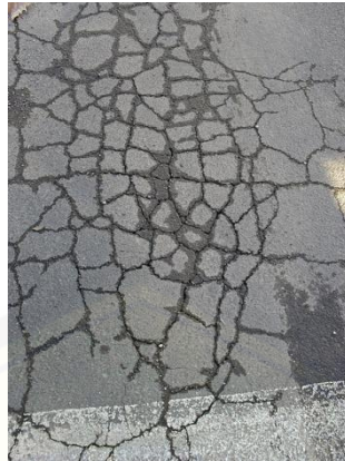
Gambar 2.8 Retak kulit Buaya
