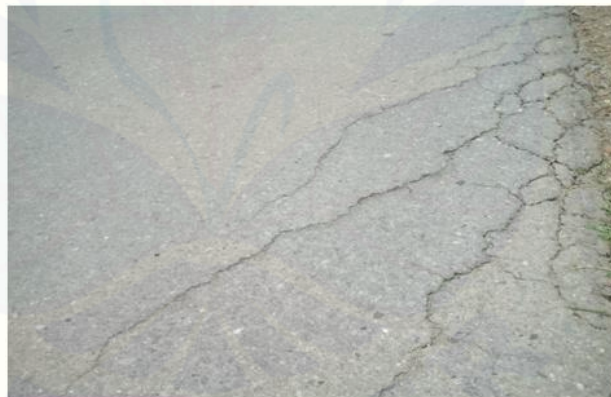
Gambar 2.9 Retak Pinggir
