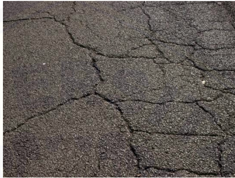
Gambar 2.14 Retak Susut
