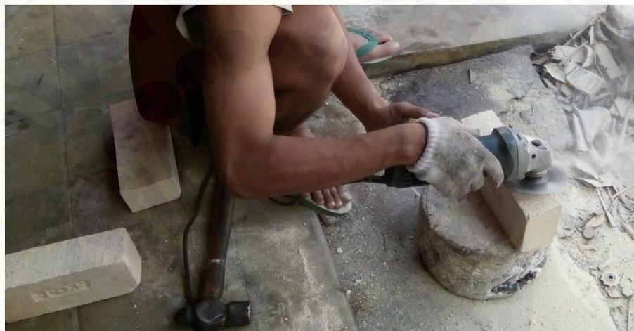
Gambar D.5 Pemotongan Bata
