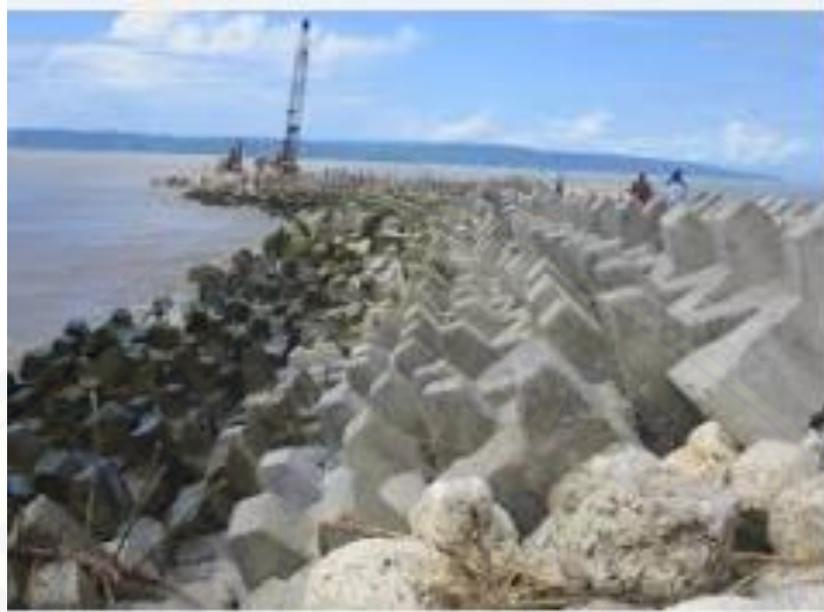
Gambar 3.2 Bangunan Pemecah Gelombang (*Breakwater*) di Pantai Puger
