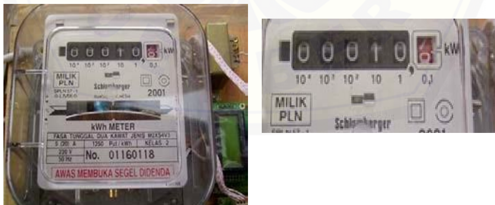
Gambar 2.6 KWH Meter Analog dan Counternya .
