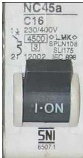
Gambar 2.2 Kode dan Simbol MCB ( www.instalasilistrikrumah.com )
