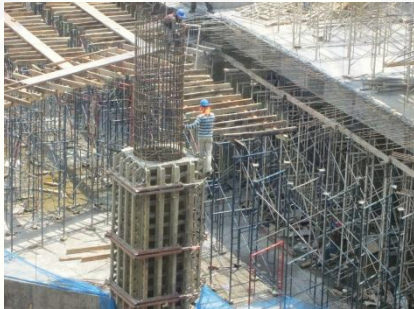
Responden tidak menggunakan APK ( full body harness ) sesuai standar
