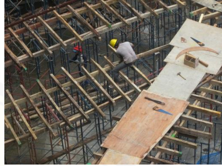
Substandard action yang dilakukan oleh responden bagian bekisting
