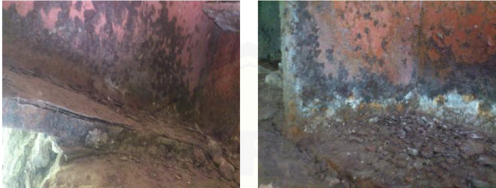
**Gambar 5.** Gelagar Induk Mengalami Korosi WF Korosi
