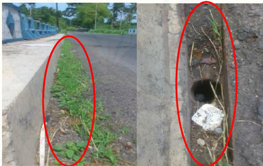
**Gambar 2.** Saluran Drainase Tertutup Tanah dan Korosi Pada Plat Baja
