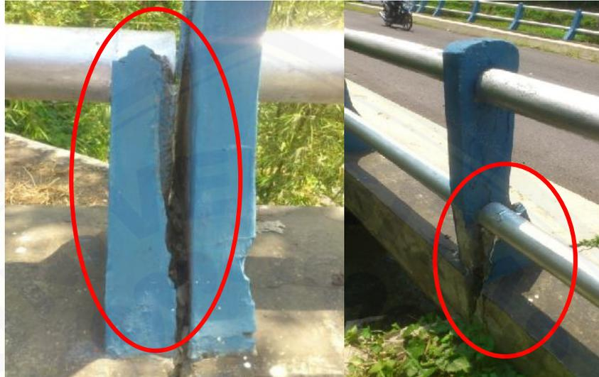
**Gambar 1.** Kerontokan Beton pada Tiang Sandaran
