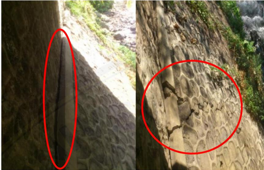
**Gambar 3. Retak Pada Talud**
