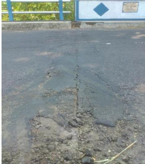
**Gambar 8.** Retak Pada Aspal karena pergerakan *Expansion Joint*
