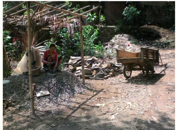
Gambar 10. Pekerja sedang bekerja memecah batu
