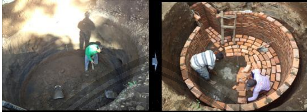
Gambar 3. Penggalian Lubang Reaktor dan Pemasangan Dinding Batu Bata pada Reaktor Biogas di Lokasi Pengabdian
