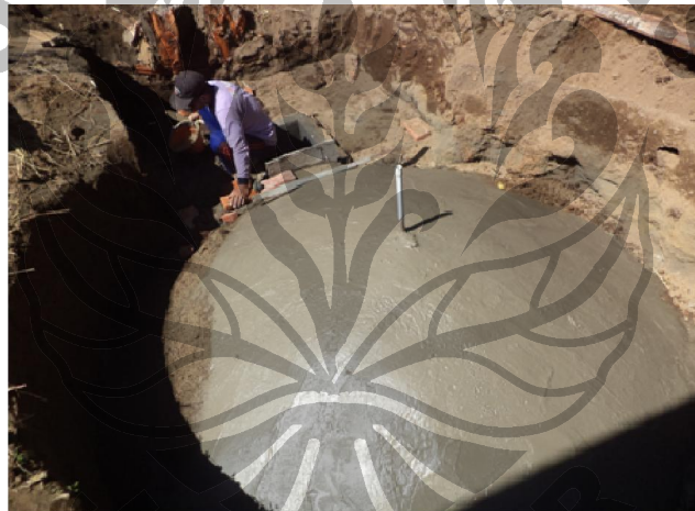
Gambar 4. Plesterisasi Kubah Reaktor
