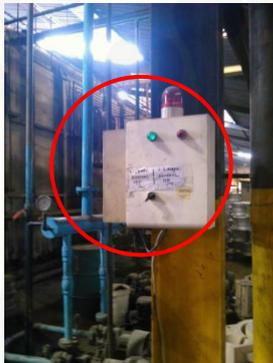
Gambar 15. *Control panel* mesin *heating* dengan petunjuk operasi
