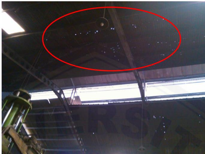
Gambar 4.21 Kondisi Atap Area Kerja *Casting* yang Berlubang
