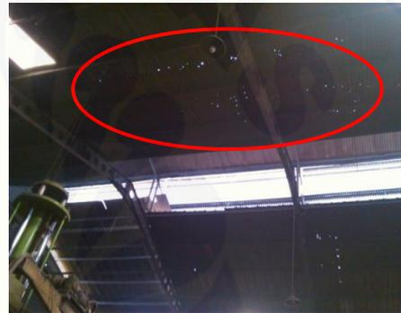
Gambar 10. Kondisi atap area *casting* yang berlubang dan berpotensi terjadinya kebocoran saat hujan
