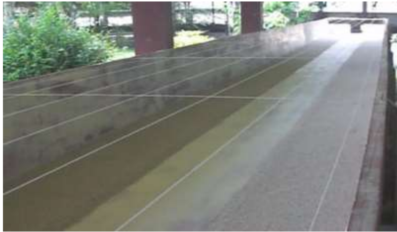
Gambar 2. Talang Saluran Laboratorium
