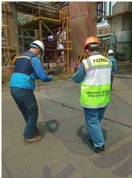
Temuan jalan rusak pada area travelling pekerjaan Hot Metal Transport PT. Purna Baja Harsco Site Krakatau Posco
