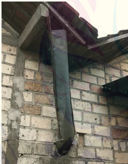
Talang-talang di rumah warga yang merupakan sarana dalam proses tadah hujan dan telah dilakukan secara turun-menurun.
