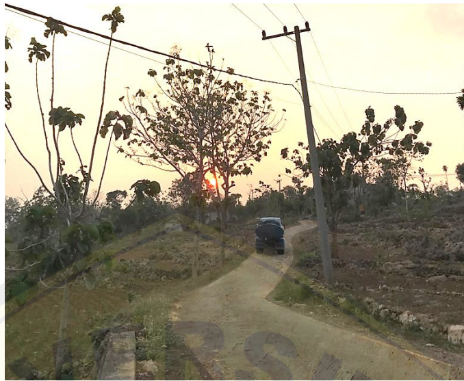
Gambar 4. 2 Jalan Menuju Desa
