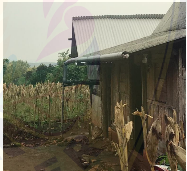
Talang-talang di rumah warga yang merupakan sarana dalam proses tadah hujan dan telah dilakukan secara turun-menurun.
