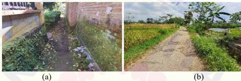
Gambar 4. 7 (a) Kondisi Jaringan Jalan Tanpa Perkerasan, (b) Kondisi Jaringan Jalan Aspal Rusak Sebagian
