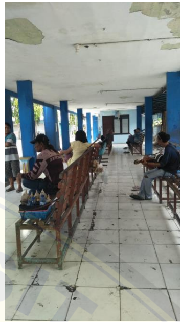
Gambar 10. Kondisi ruang tunggu penumpang
