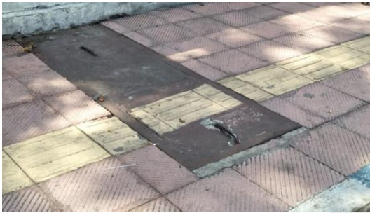
Gambar 12. Kondisi pembuangan limbah cair dan drainase
