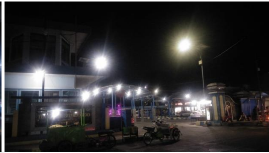
Gambar 6. Penerangan pintu keluar terminal
