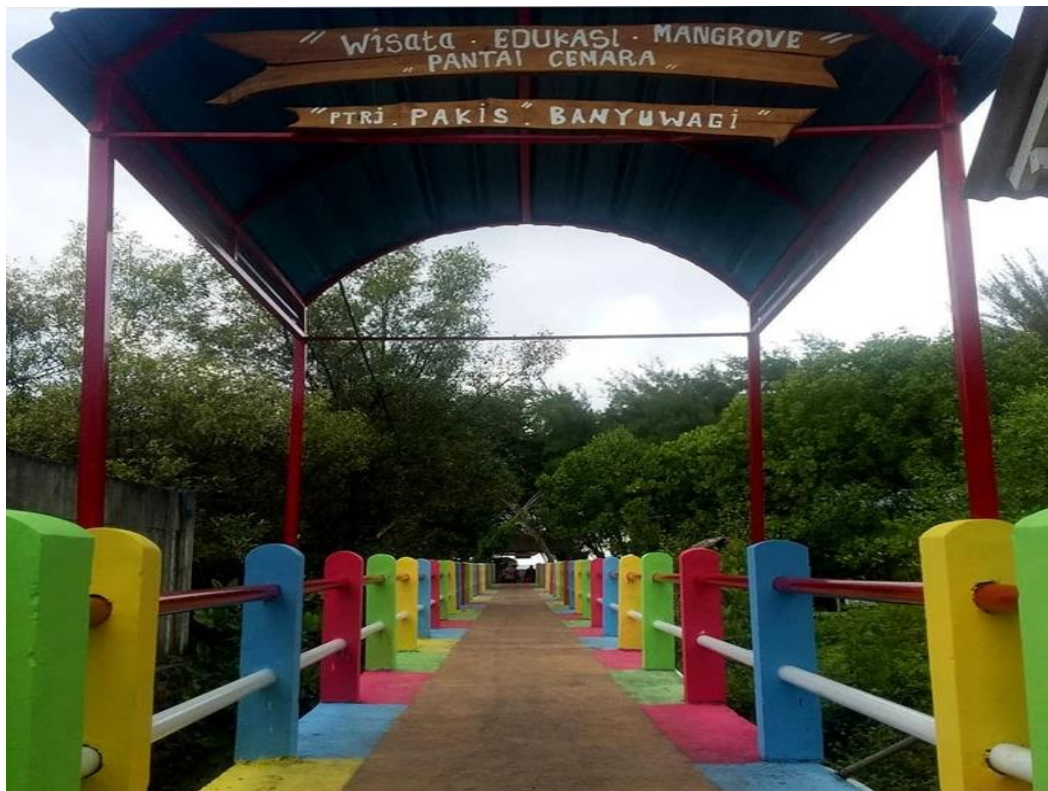
Gambar 4.18 Jembatan Akses Menuju Pantai Cemara Tahun 2017
