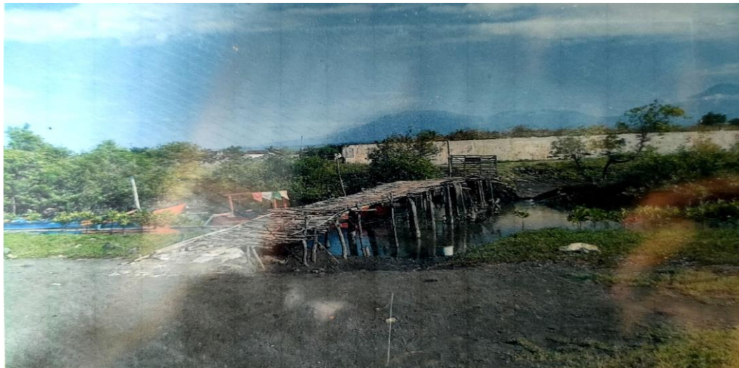
Gambar 4.2 Jembatan Akses Menuju Pantai Cemara Tahun 2011
