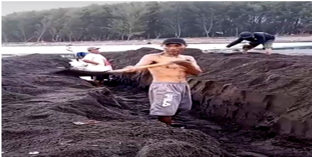
Gambar 4.13 Kegiatan Anggota KUB Yang Membuat Lubang Saluran Untuk Memindahkan Muara Pantai Yang Berpindah-Pindah Tahun 2015.
