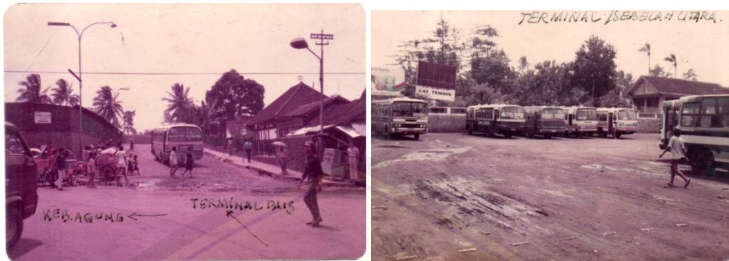
Gambar 3.2 Gerbang dan halaman utama Terminal Gebang utara bagian tempat pemberhentian otobus (Sumber: Dinas Perpustakaan dan Kearsipan Kabupaten Jember)
