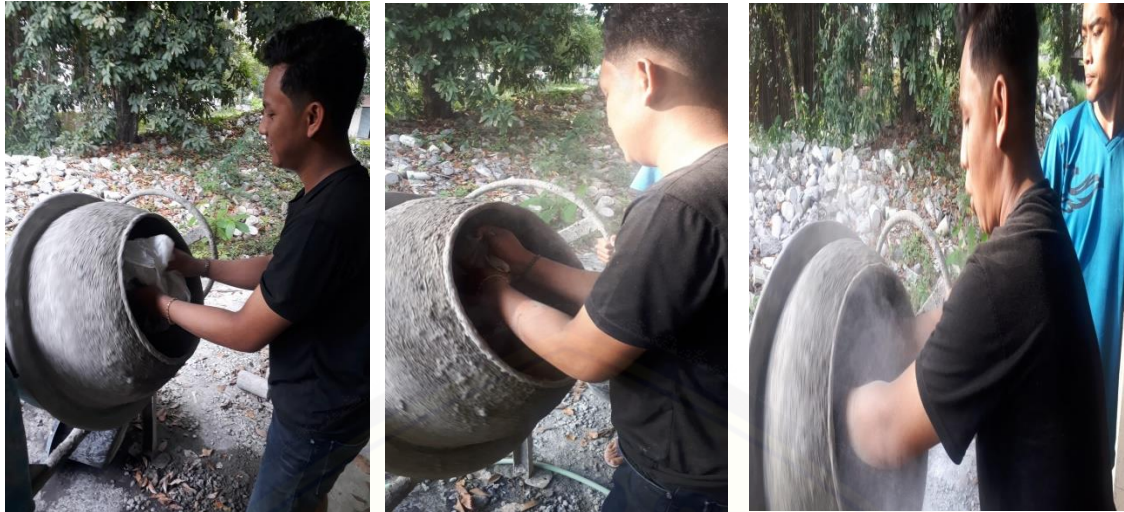
Lampiran B.5 Foto Kegiatan Penambahan Beberapa Material dan Bahan Tambah Abu Sekam Padi Dalam Proses Pengecoran
