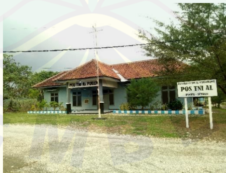
Gambar 4. 17 Kantor Pos TNI AL (Sumber: Survei primer 2022)
