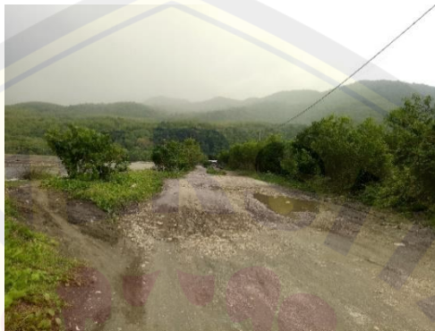
Gambar 4. 6 Kondisi Jalan 2 (Sumber: Survei primer 2022)
