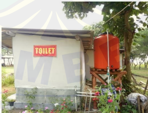
Gambar 4. 13 Toilet (Sumber: Survei primer 2022)
