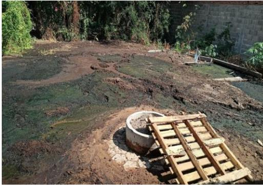
Outlet untuk mengeluarkan kotoran yang telah difermentasi oleh bakteri berupa residu dari pembuatan biogas
